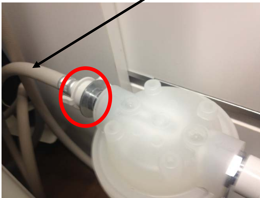
給水ホース交換
