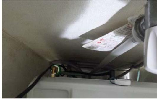
排水口の設置は先にOED本体設置位置を固定してから排水固定を最後に行うほうが
