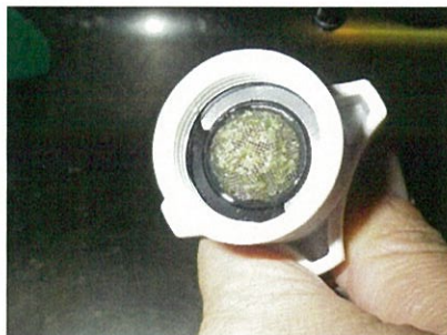
写真1：給水ホースのストレーナ
