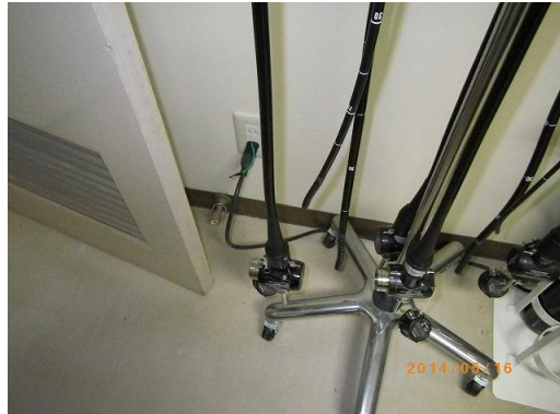
写真2:OEDが使用している壁コンセント ※アースなし 2P壁コンセント
