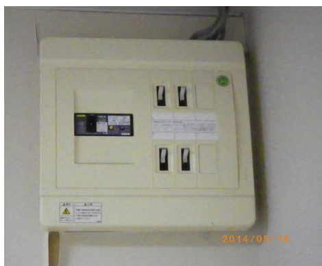
写真4:分電盤 主幹:30Aのブレーカ
