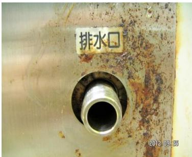
写真6:排水口 付着物除去後
