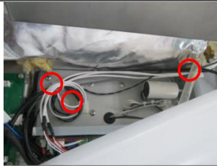
②ポンプが取り出せるようにチューブを外す。第 1 ロット～第 4 ロットの場合 (No.100001～100192)
