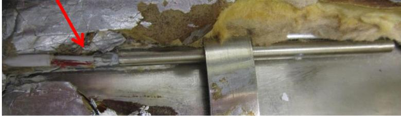
1) 排水タンク脇の断熱材を触り、缶体温度センサーの位置と温度ヒューズ固定バンドの位置を確認する。
