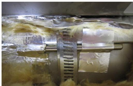
7) 缶体温度センサーの先端にシリコン材を塗り、筒の突き当たりまで入れる。
